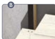
B Taśma EPDM do zabezpieczenia otwartych fug 100x0,75mm L=20m
